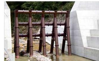
鋼製砂防堰堤(荷重・エネルギー設計)
